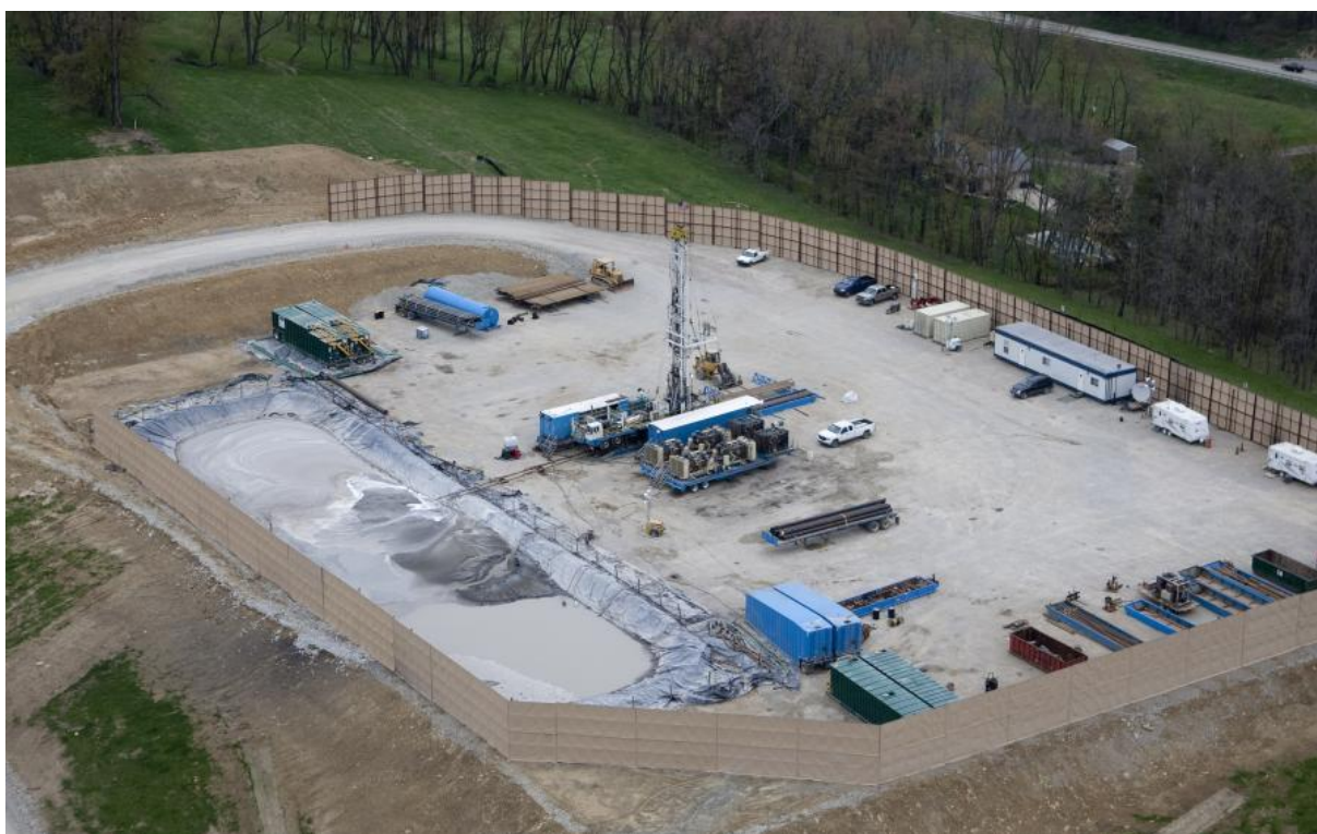
Dzięki takim miejscom możliwe jest wydobycie gazu łupkowego - Canonsburg w Pensylwanii, USA. Platforma wiertnicza
